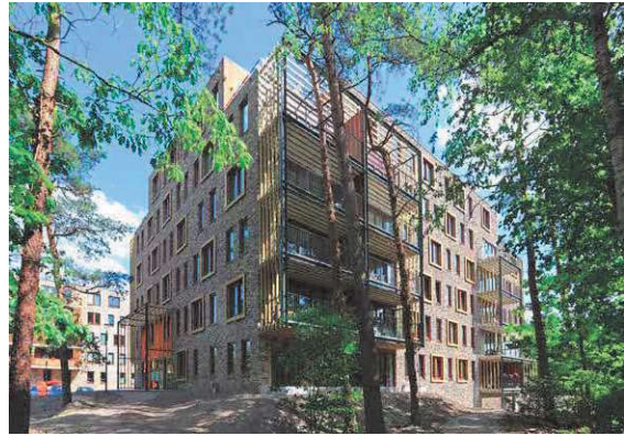
Gestapelde sociale woningbouw - Berkeveste, Denneveste; Kerkebosch (bron: mix-architectuur.nl )
