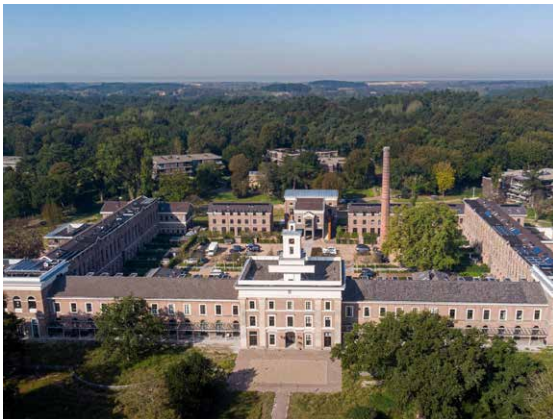
Geschakelde woningen in het topsegment Park Brederode, Bloemendaal (bron: heiligers.nl )
